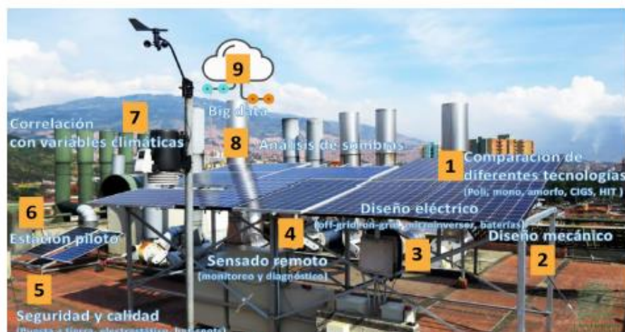
Figura 1. Estación solar SIU-UdeA. Montaje experimental
