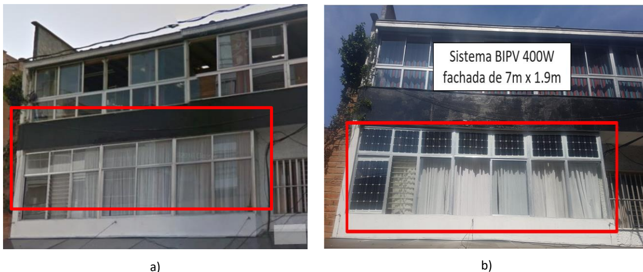
Figura 4-16: a) Fachada de instalación del caso de estudio b) Montaje del sistema BIPV.
