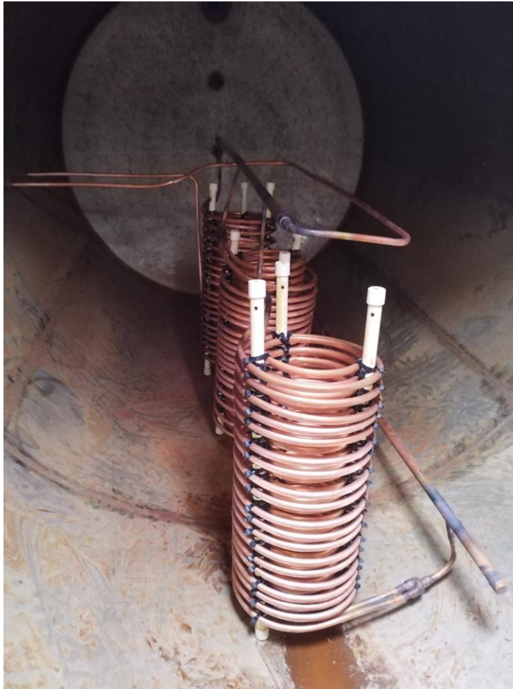
Ilustración 11: Intercambiadores de calor de cobre por convección natural en tanque de acumulación. Fuente propia
