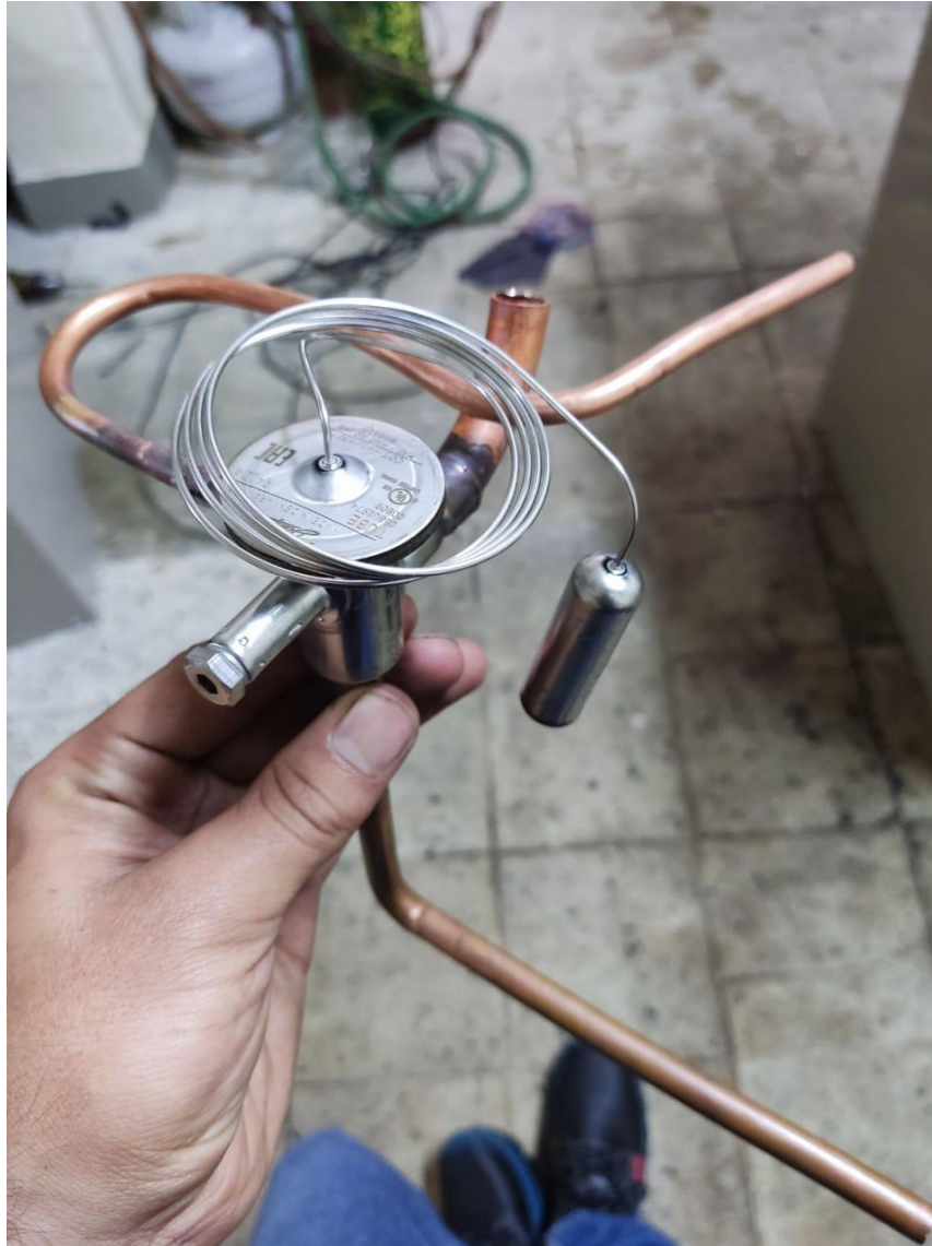
Ilustración 17: Válvula de expansión termostática. Fuente propia
