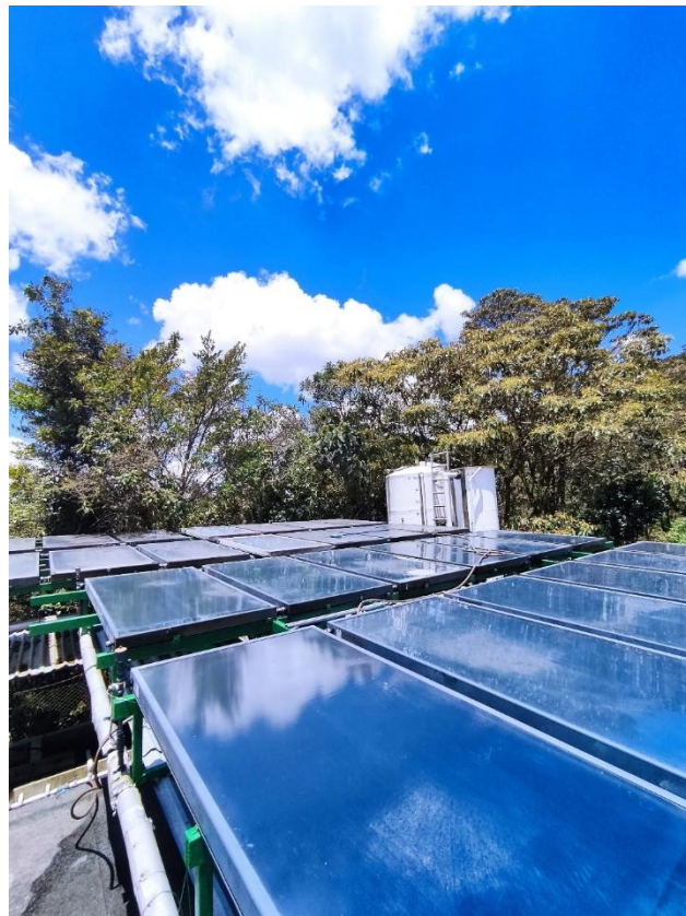
Ilustración 32: Colectores solares de placa plana en Eco Hotel Piedras Blancas Fuente propia
